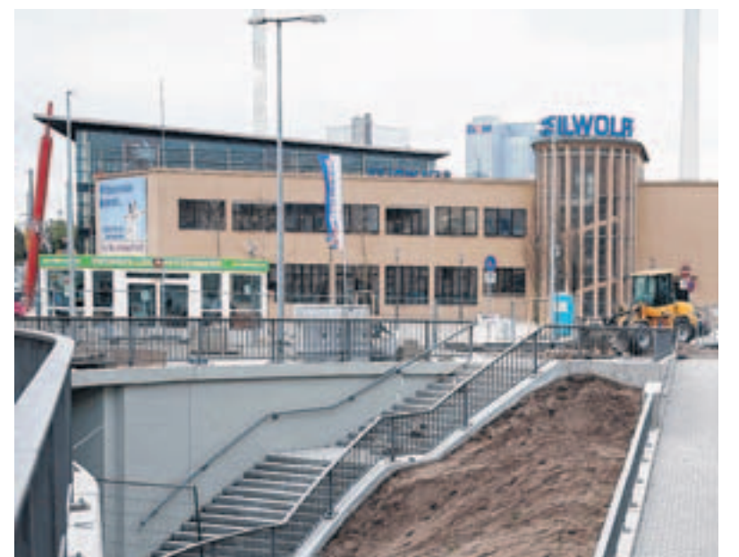
Ziehen sich noch hin: Die Bauarbeiten am Vorplatz des Seilwollf-Centers in Neckarau. Bis Mitte Juni soll aber alles fertig werden. BILD: RITTELMANN
