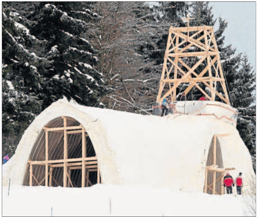
Eine Kirche aus Schnee entsteht in Mitterfirmiansreut. Bis Ende Dezember sollen für die Kirche rund 1100 Tonnen Schnee verbaut werden. In dem rund 26 Meter langen und 11 Meter breiten Gotteshaus aus Schnee sollen 190 Menschen Platz finden. Jetzt steht das Projekt auf der Kippe. Bild: dpa
