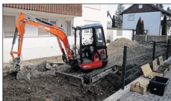
Ein Bagger steht vor einem Haus im Stadtteil Freimann in München, in dessen Garten große Mengen an Sprengstoff gefunden wurden. Bild: dpa
